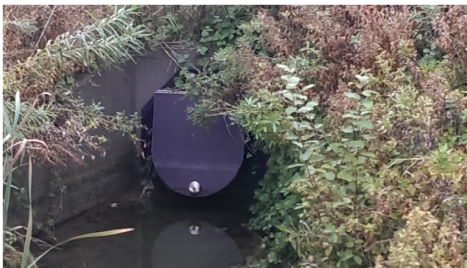
Figur 2-15 Overløb fra rørbassin umiddelbart nord for vejen Over Engen
