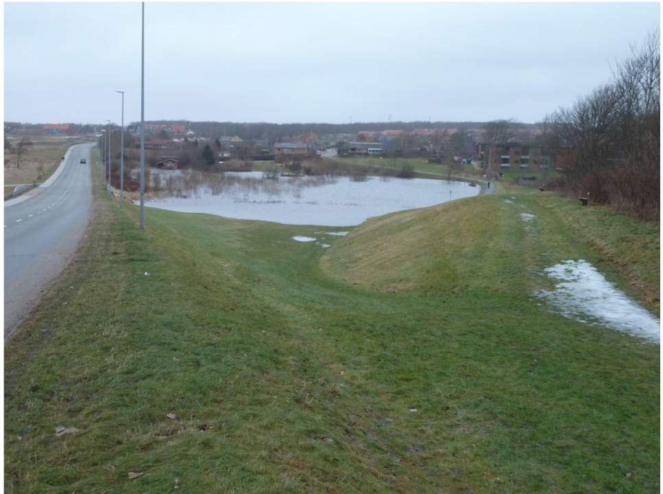
Figur 2-11 Billede af oversvømmet området ved bygværk syd for Over Engen. Billedet er taget 16. januar 2011
